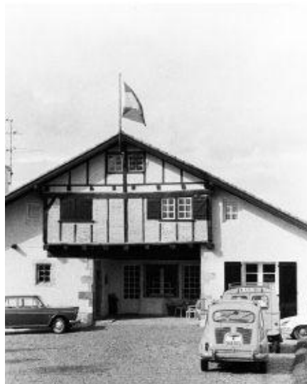
Residencia real de la dinastía carlista. Residencia Valcarlos, en Arbonne, Francia.
